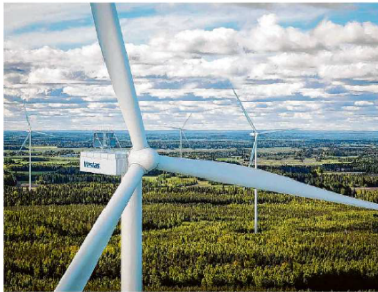
Das Firmenfoto zeigt Windkraftanlagen vom Typ Vestas V172 mit einer Nabenhöhe von 175 Metern, wie sie auch für den Schurwald beantragt sind, an einem anderen Standort. Foto: Vestas
